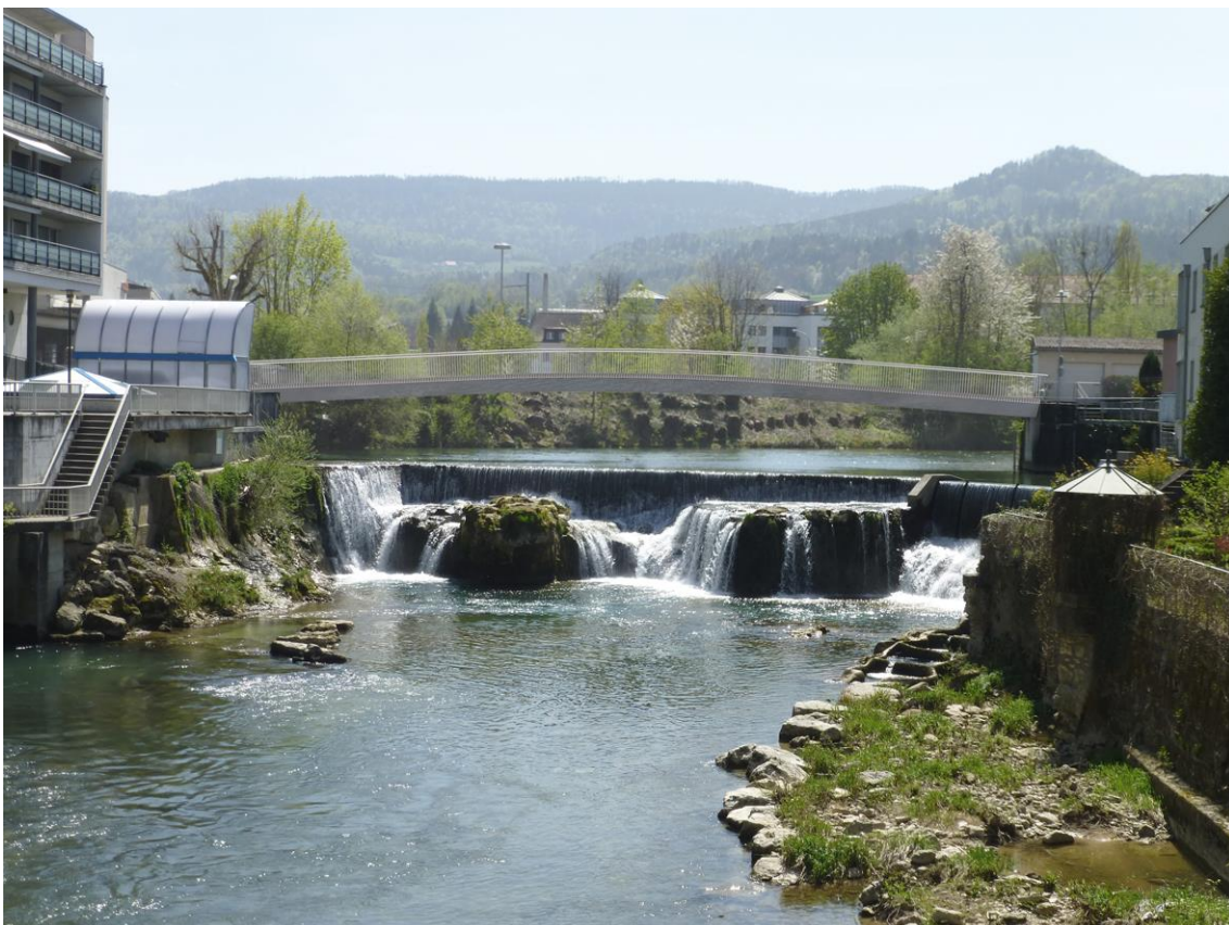
Ansicht von der Brücke Bahnhofstrasse.
