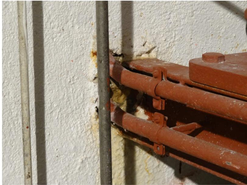
**Abbildung 2: Undichtes Mauerwerk**
