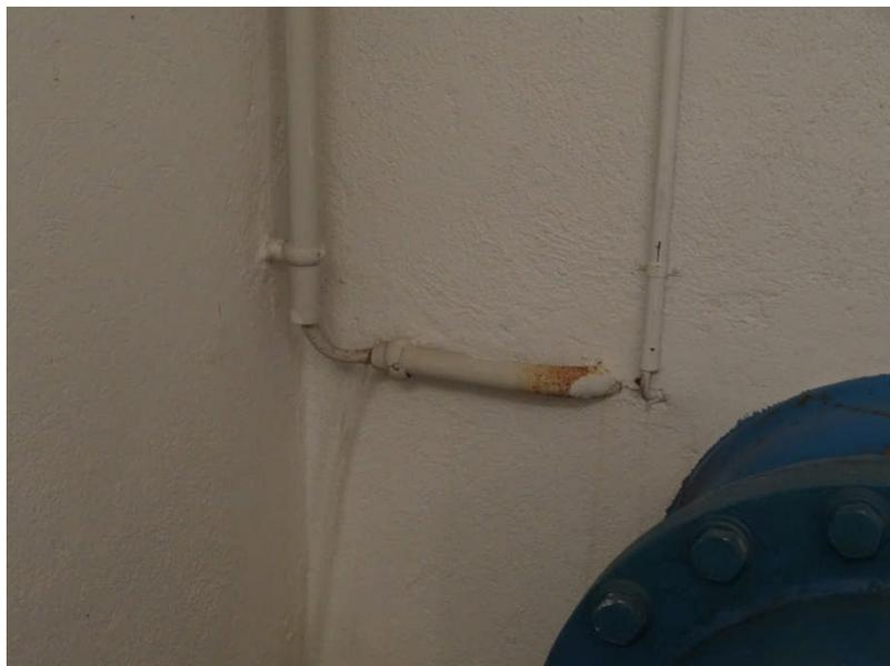
Abbildung 1: Undichte Kabeleinführung
