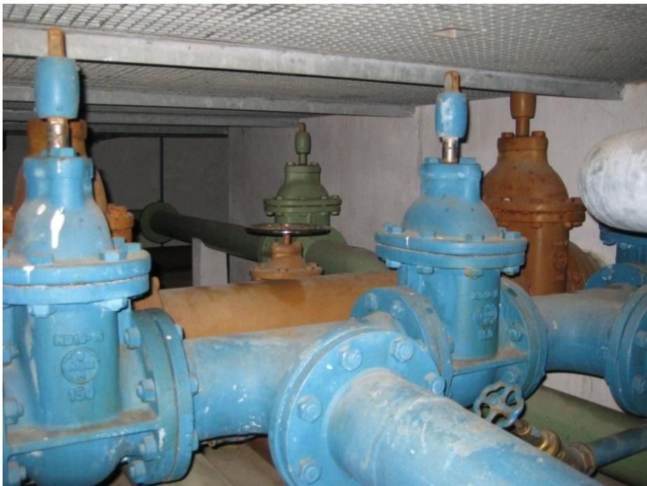
Abbildung 5: Nicht mehr benutzte Rohrleitungen und Armaturen
