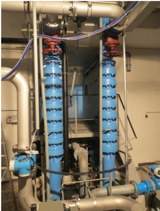
Abbildung 2: 2-stufige Bohrlochpumpen (blau)
