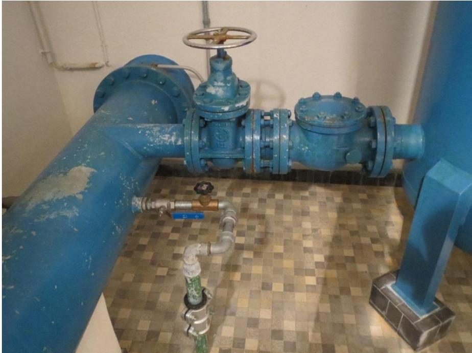
**Abbildung 4: Rohrleitungen und Armaturen mit abgenutzten Beschichtungen**
